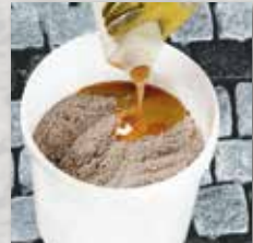
Bindemittelkomponente zugeben
