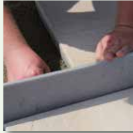
vdw 884 FugenBand im Bettungsmörtel einbringen
