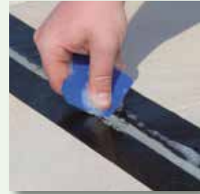
Fugenmasse verdichten und abziehen
