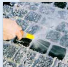
mit Wassersprühstrahl und feuchtem Besen abreinigen
