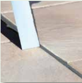
Klebebänder direkt im Anschluss entfernen
