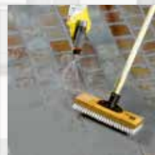
diagonal zur Fuge abreinigen
