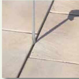
Fugenbandreste komplett entfernen
