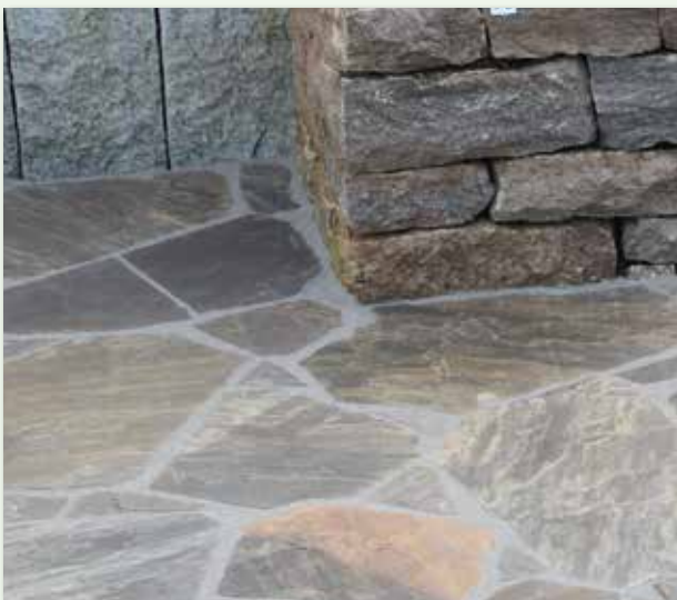
Bei Plattenverbänden mit breiten Fugen eignet sich vdw 850 plus bestens zur Fugenfüllung.
