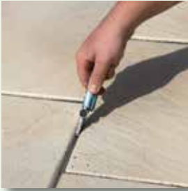
Hierzu Schnittkante FugenBand einkerben
