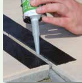
Kanten sauber abkleben und vdw 885 plus FugenFlex mit Druck blasenfrei einspritzen
