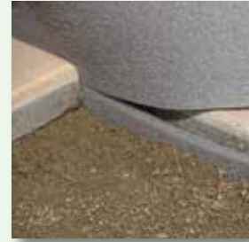
vdw 884 FugenBand 10 mm tief abtrennen
