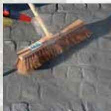
Erhärten des Mörtels auf der Oberfläche vermeiden
