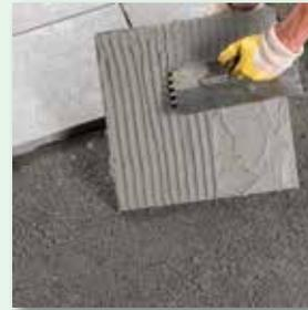
Bei Platten unterseitig vdw Universal-HaftBrücke auftragen
